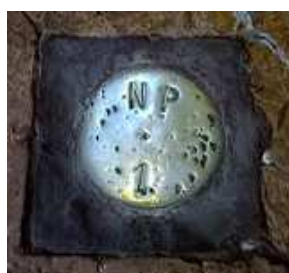
El NP1 se representa con un clavo de bronce que indica el «datum altimétrico».
